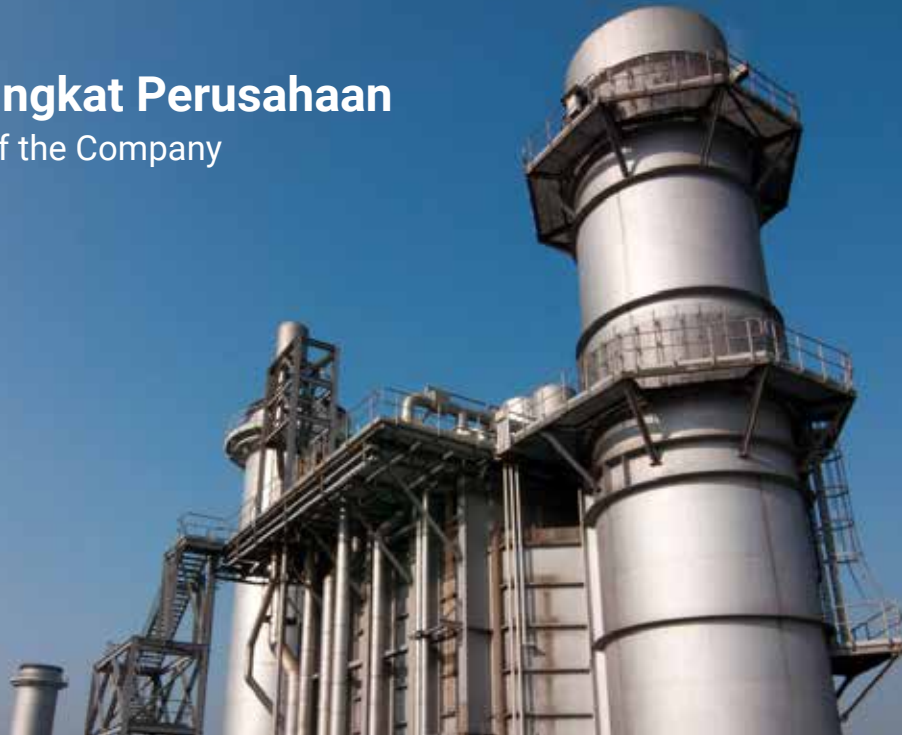
▲ Turbin Gas Frame 9E PLTGU Jababeka Gas Turbine Frame 9E at GSPJ Jababeka
