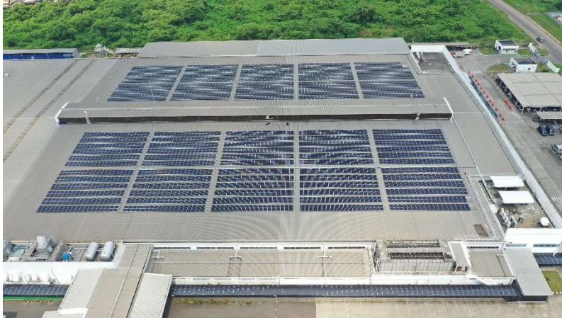
PLTS Atap di atap pabrik PT Denso Manufacturing Indonesia sebesar 1,6 MWp
