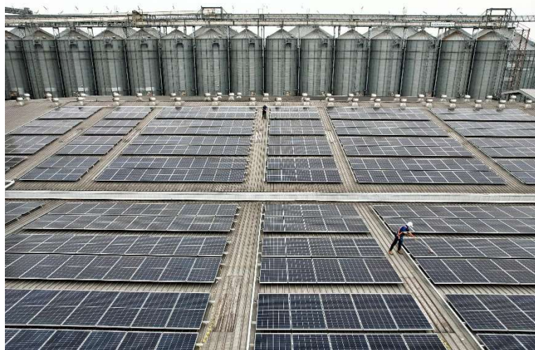
PLTS Atap di atap pabrik PT Indofood Sukses Makmur Tbk sebesar 1 MWp
